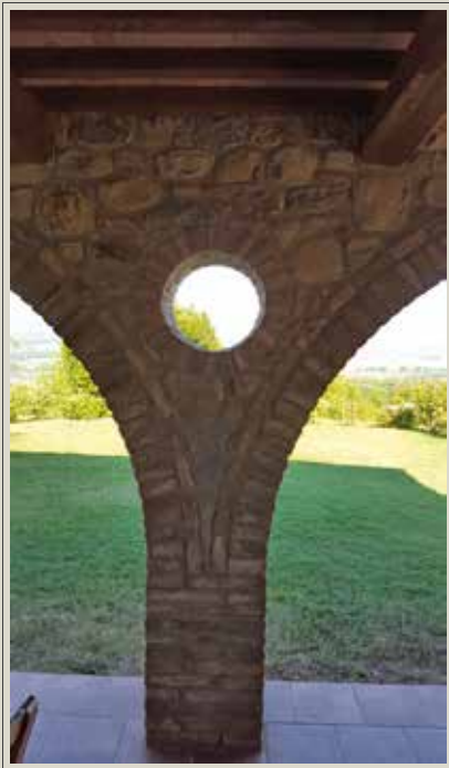
Sistemazione di locali interni nel quadro della ristrutturazione edilizia con ampliamento di fabbricato rurale in Monteleone d'Orvieto, loc. Farnietino S.Maria, particolare nuove arcate del portico esterno
