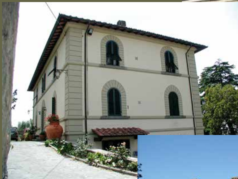
Ristrutturazione palazzo storico
