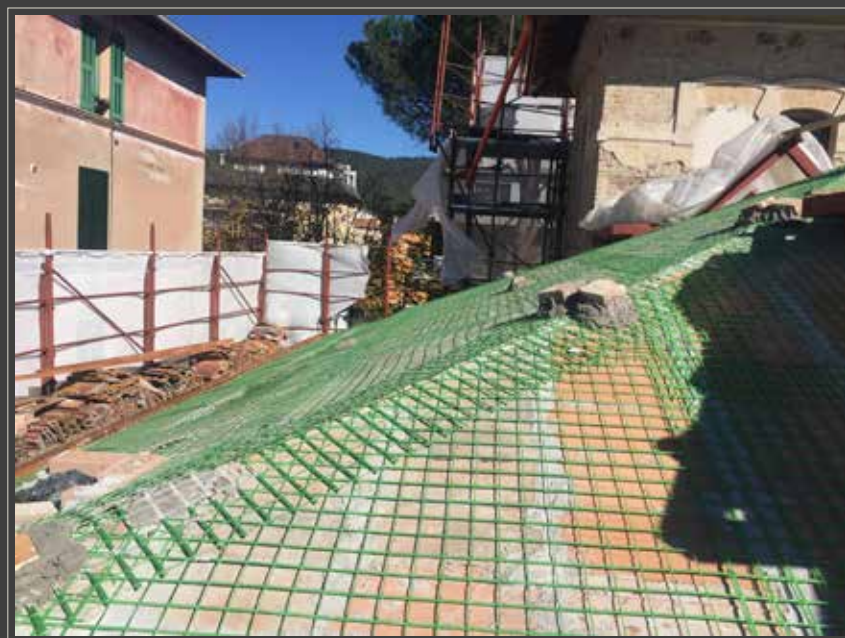
Fibra di vetro Fibranet per miglioramenti e adeguamenti sismici
