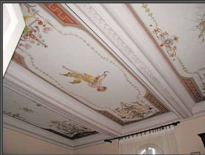
Recupero affresco soffitto su palazzo storico
