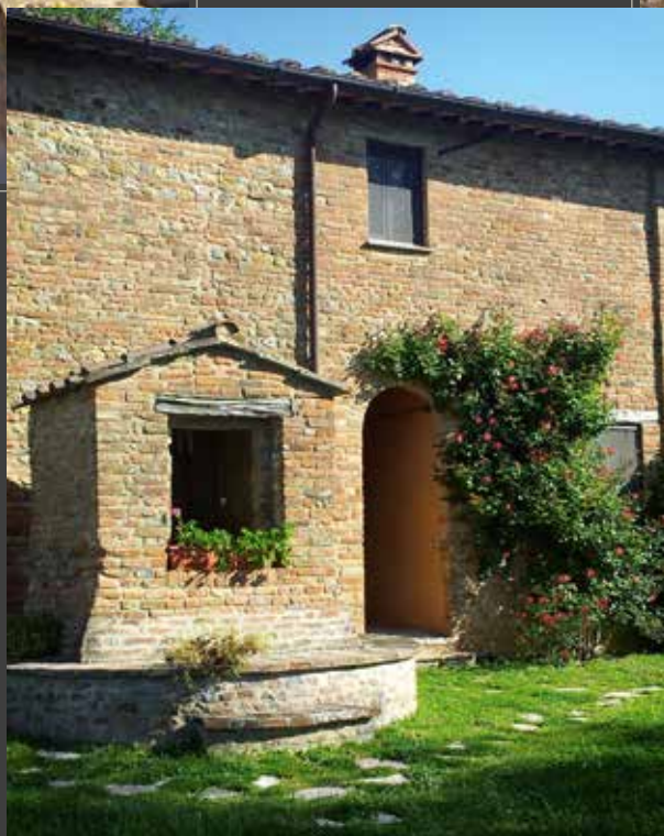
Restauro conservativo di fabbricato rurale tipico BA al vocabolo Cassero I a Città della Pieve con annesso recupero del vecchio pozzo esistente
