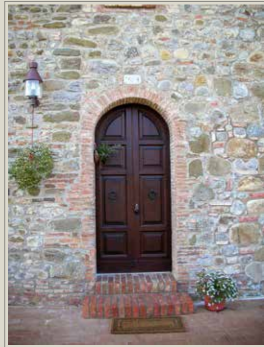
Intervento di restauro conservativo di fabbricato rurale tipico BA in Città della Pieve, voc. Pozzolino II, particolare del rifacimento del portone di ingresso di foggia tipica
