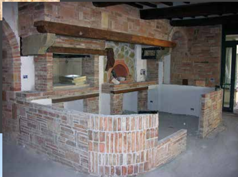
Esecuzione di camino e forno pizza in muratura e architravature in legno di quercia
