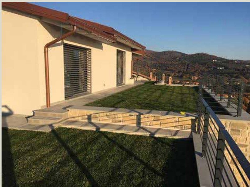
Nuova costruzione villa monofamiliare Dettaglio giardino pensile
