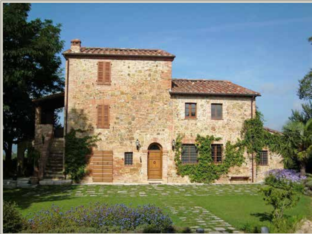
Ristrutturazione edilizia con ampliamento di fabbricato rurale in Città della Pieve al vocabolo Santa Maria degli Angeli, restauro parte esistente
