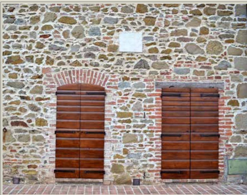
Ripulitura e stuccatura con rinzafo storico facciata casolare
