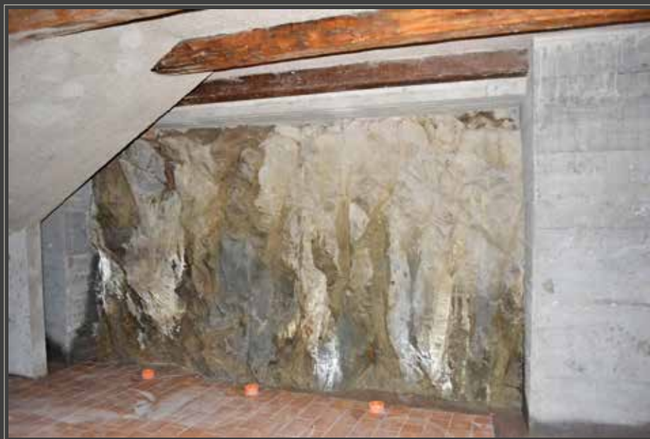
Formazione di cantina interrata con parete in roccia a vista
