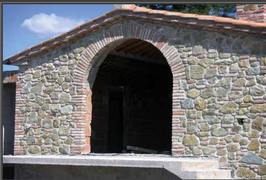
Muratura faccia vista con pietra arenaria tipica delle zone lacustri
