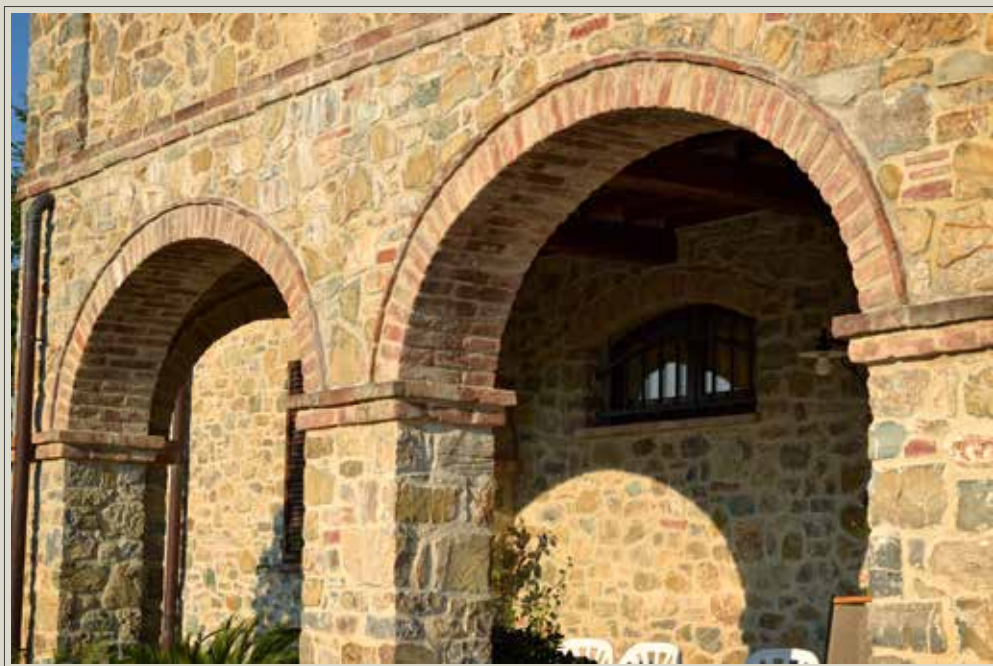
Porticato con archi a mattoni e muratura a pietra faccia vista
