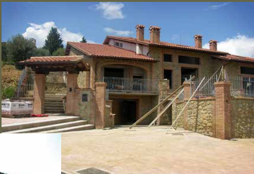
Realizzazione di villette bifamiliari con rifiniture esterne ed interne di pregio
