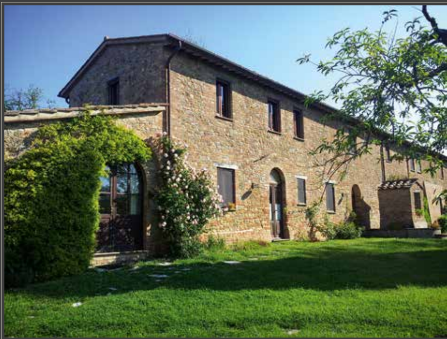
Restauro conservativo di fabbricato rurale tipico BA al vocabolo Cassero I a Città della Pieve con annesso recupero del vecchio pozzo esistente
