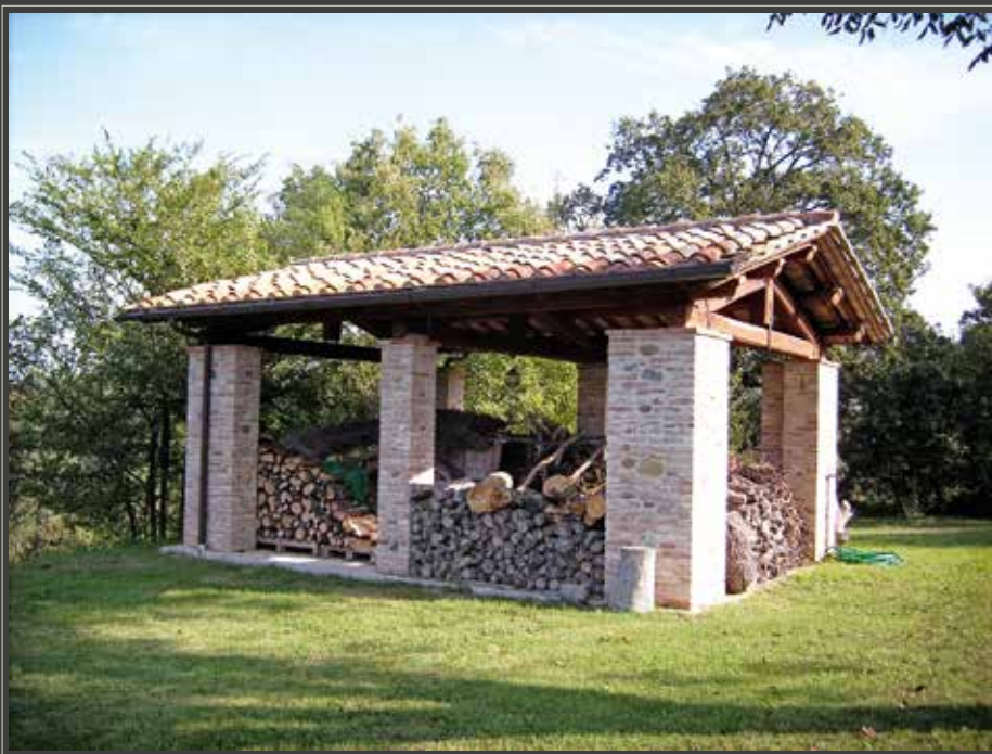
Ristrutturazione edilizia con ampliamento di fabbricato rurale in Città della Pieve al vocabolo Santa Maria degli Angeli, particolare della ricostruzione della vecchia legnaia tipica
