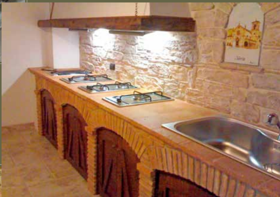
Cucina in muratura eseguita con pianelle a vista e legno massello
