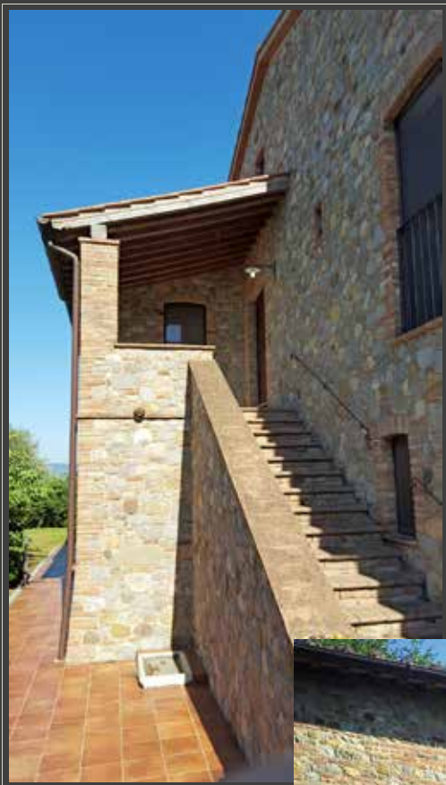
Sistemazione di locali interni nel quadro della ristrutturazione edilizia con ampliamento di fabbricato rurale in Monteleone d'Orvieto, loc. Farnietino S.Maria, particolare del rifacimento della scala di accesso tipica
