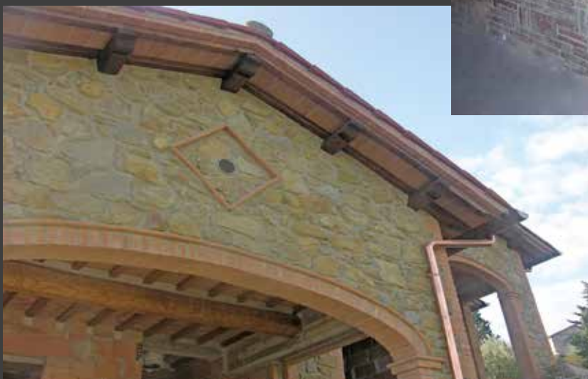
Facciata in pietra con rifiniture di pregio
