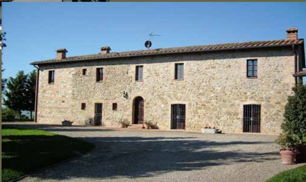
Intervento di restauro conservativo di fabbricato rurale tipico BA in Città della Pieve, voc. Pozzolino II
