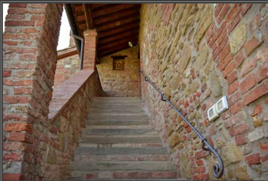
Realizzazione di scala in pietra serena e mattoni con corrimano in ferro battuto
