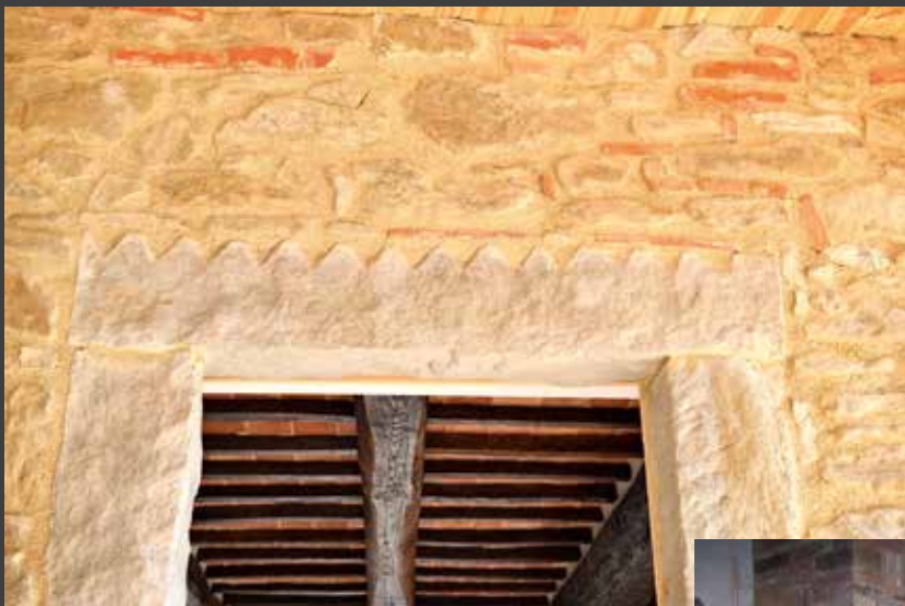
Ripristino vecchio architrave porta
