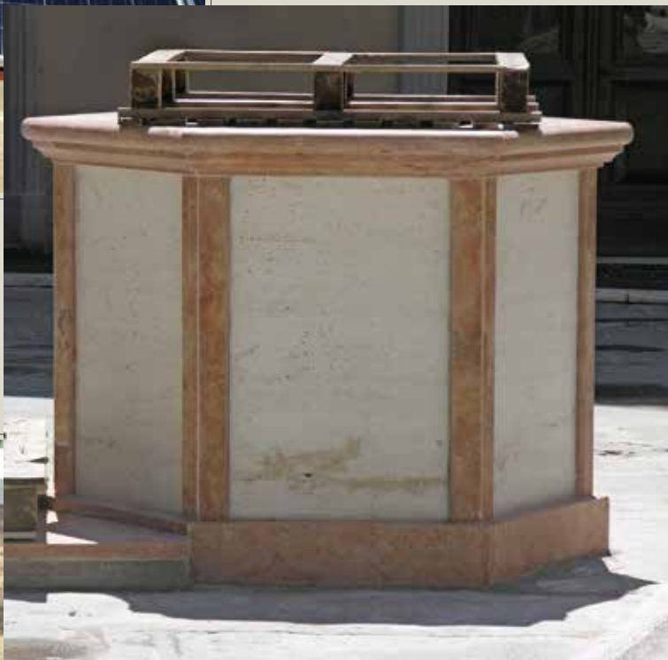
Ripristino di pozzo etrusco a forma esagonale con travertino bianco e travertino rosato
