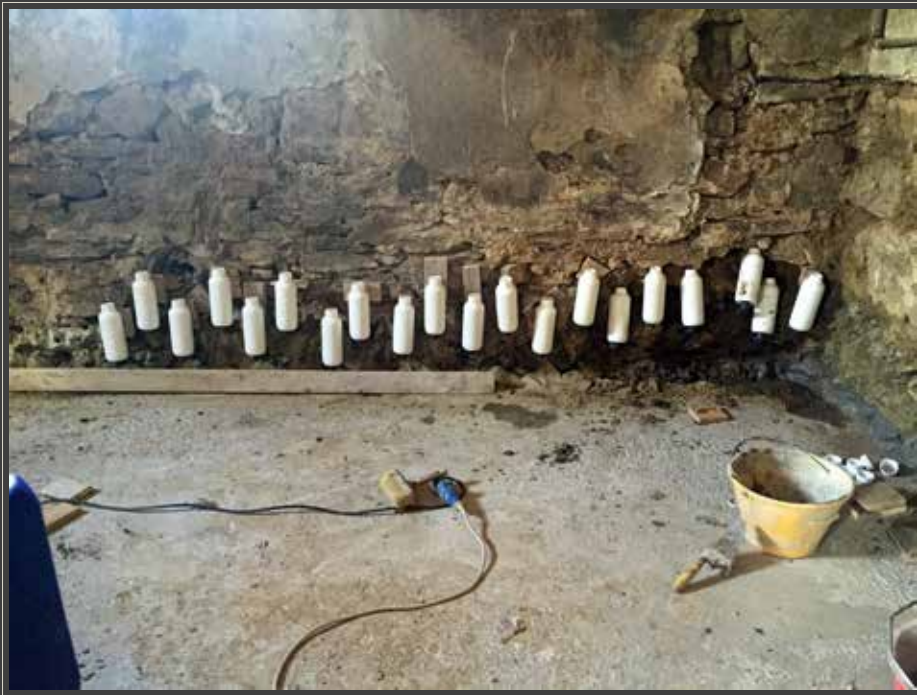
Barriera chimica con tecnologia per recupero edilizio tramite esecuzione di barriera chimica con prodotto KIMIA Kimikover In
