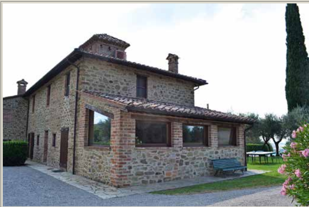
Restauro conservativo di fabbricato rurale in località Paciano voc. Torrione
