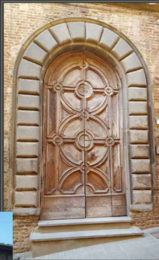
Restauro conservativo e integrazione di parti del vecchio portone ligneo del '600 di Palazzo Bandini in Città della Pieve, intervento eseguito con supervisione BAAAS
